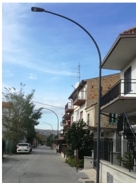
Nuovo impianto stradale a LED
