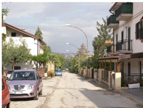
Prima dei Lavori
