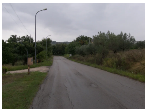
Situazione ante lavori
